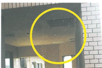
配水管の漏水。(丸で囲んだ部分)
